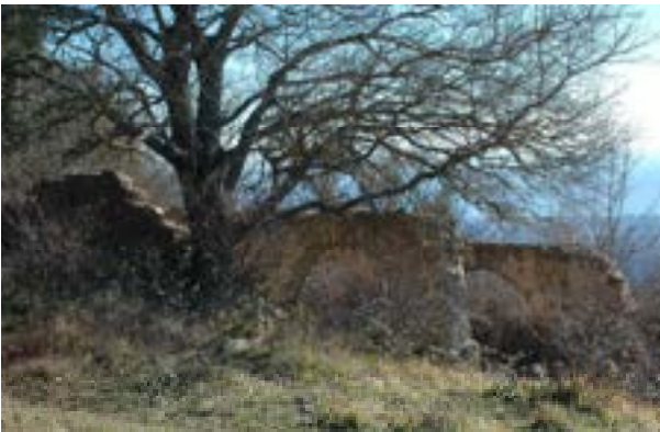
Bergerie en ruine - Courmettes
