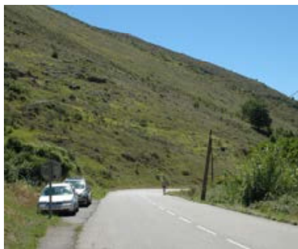
Route de Vence : multiplication des poches de stationnement sauvages et piétons sur chaussée
