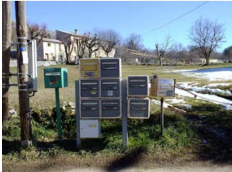
Hameau de Saint barnabé, des équipements à intégrer afin qu’ils s’estompent face à la qualité du lieu
