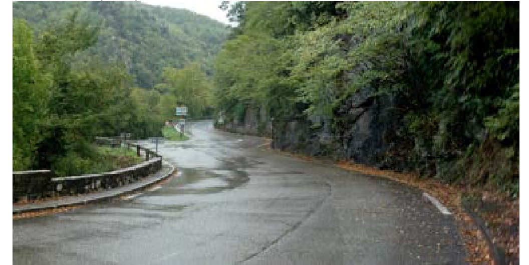
Porte routière, RD3, carrefour de Bramafan à Courmes
