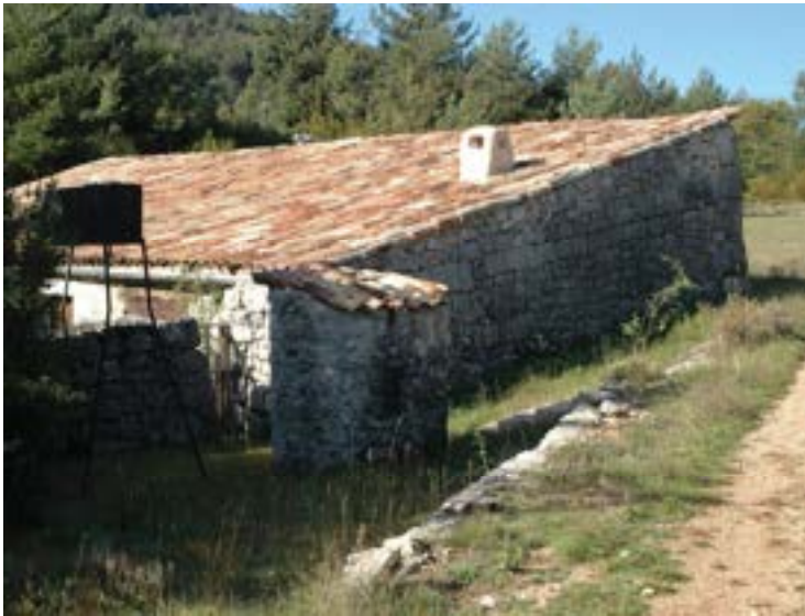
Coursegoules : bâti agricole traditionnel simplicité des volumes, unicité des matériaux
