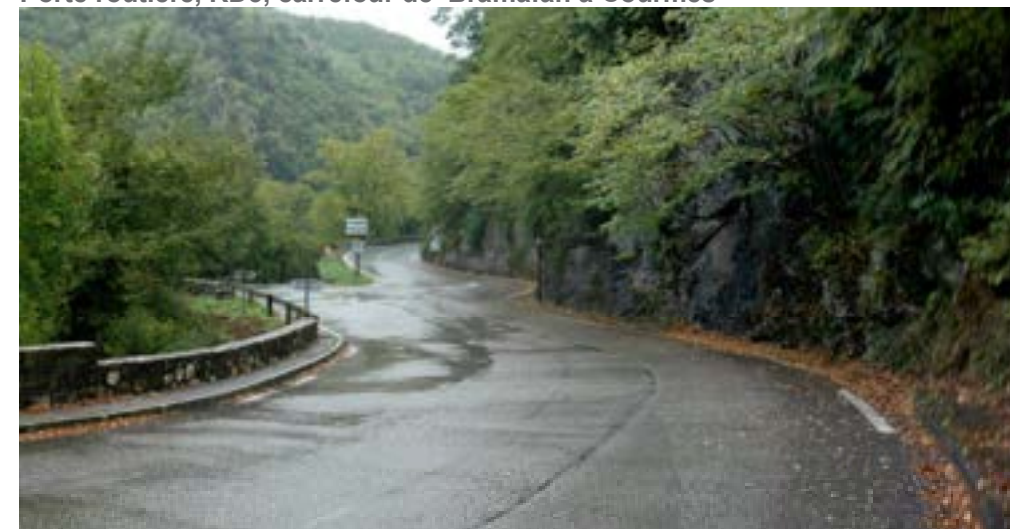
Porte routière, RD3, carrefour de Bramafan à Courmes
