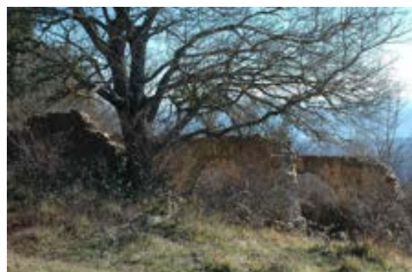
Bergerie en ruine - Courmettes
