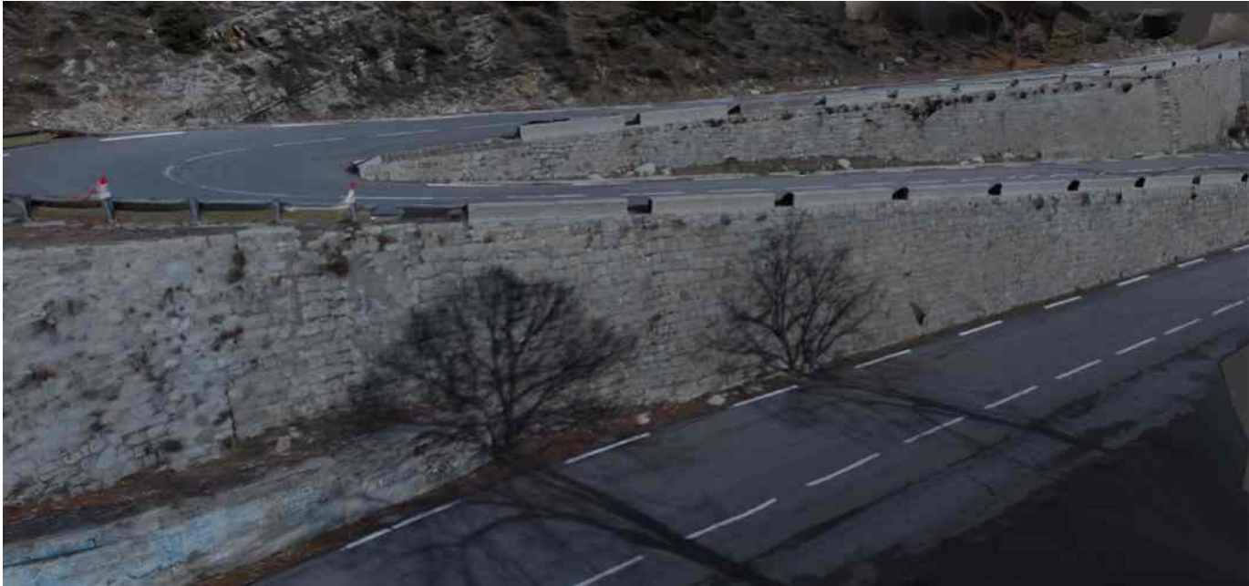
OUVRAGE DE SOUTÈNEMENT ROUTIER DU COLS DE LAUS (SO4)
