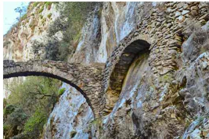
VIADUC DU VALLON DE LA BANDOLA À SAORGE (SA1)
