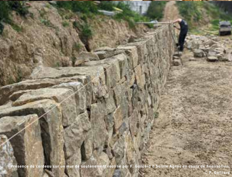
Contrôle du pendage d'un mur de soutènement en cours de construction à Vence.
