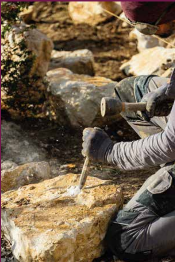
Vincent Murailleur Le Bar-sur-Loup Façonnage léger à la massette portugaise et au poinçon et contrôle de la verticalité de la chaîne d'angle © A. Mattaix - PNR PA
