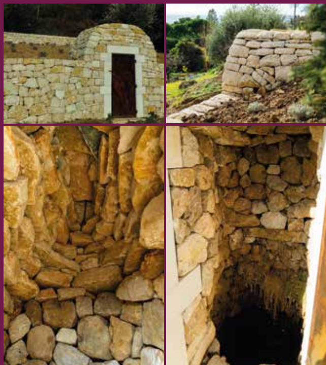
Puits fermé avec voûte en encorbellement et voie en calade réalisés par V. Lugeux à Vence © A. Mattaix - PNR PA
